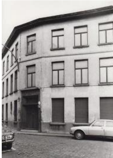
Gevel van het bedrijfje Filature et Tissage Vincent, aan de Korianderstraat
